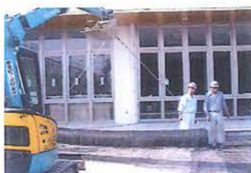
エックスグリッド敷設
