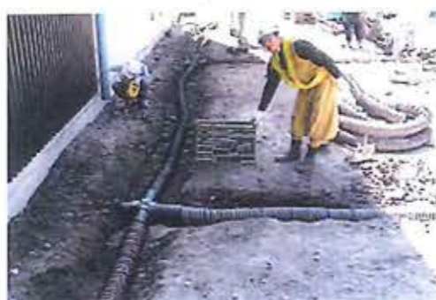
透水管布設状況
