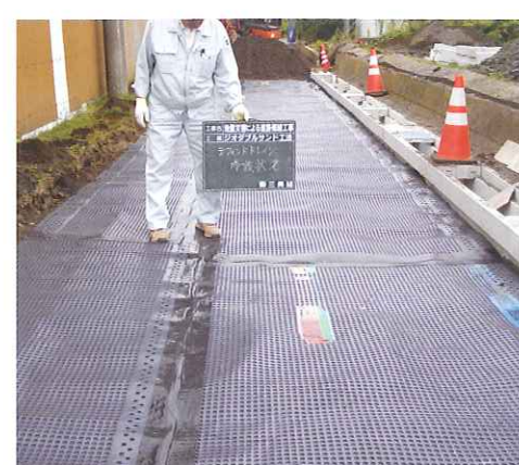
▲【施工手順②】防水シートのテフオンドレイブラスを敷く
