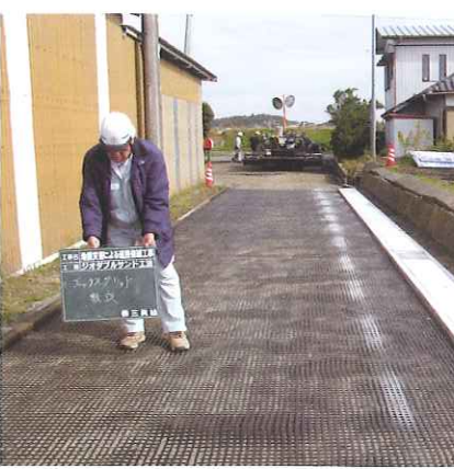
▲【施工手順③】補強シートのエクソグリッドは縦方向と横方向に繊維が走っている
