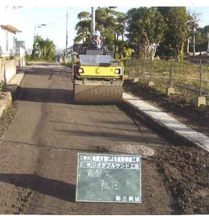
▲【施工手順④】土を重ねてローラで整える
